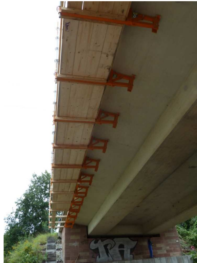
■ Bruchmühlbach, Brücke BAB A6
